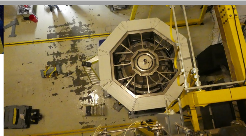
PE shielding installation
